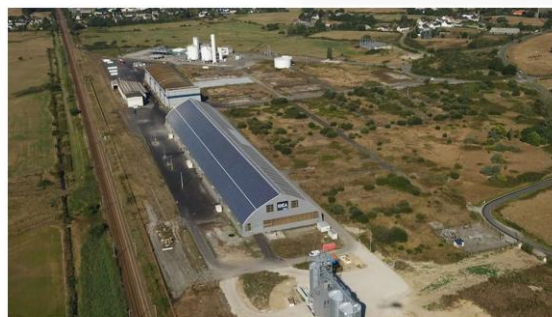
L'ancien site Seveso de Montoir, en cours de conversion. (André Bocquel)
