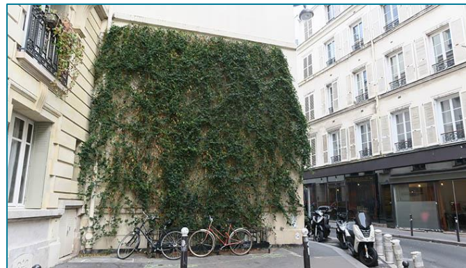
Végétalisation sur mur aveugle
