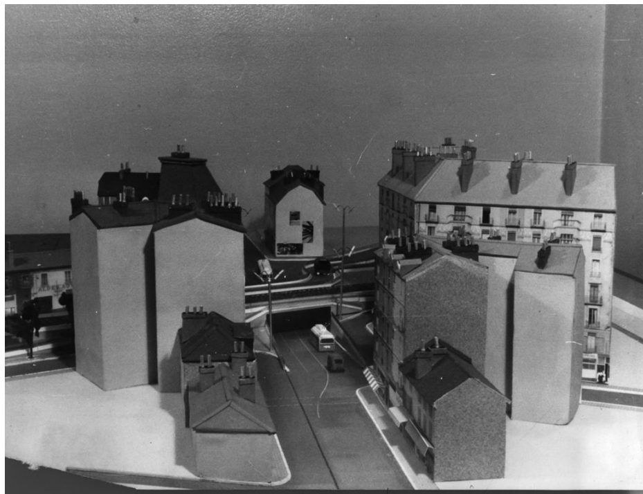
Fonds AMMG, 3 FI 126, Estacade Cours Berriat, maquette du pont, photographies, 1964
