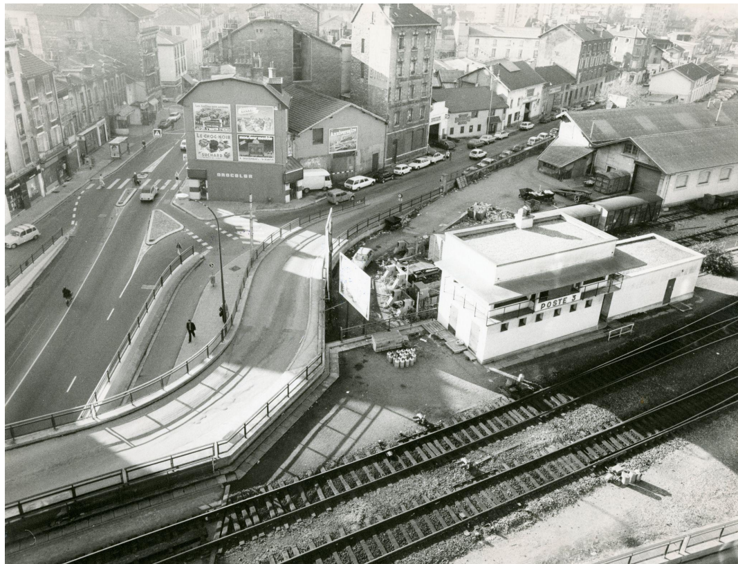
Fonds AMMG, 597 W 6, Cours Berriat, sites urbains ou chantiers, photographies, 1982
