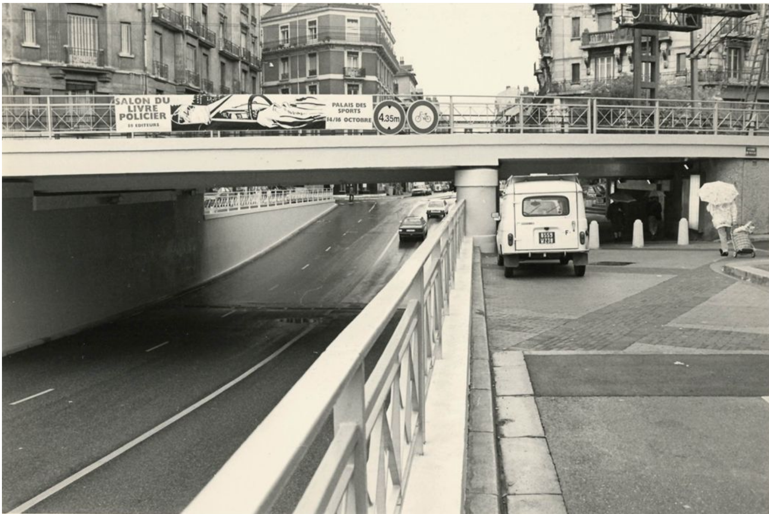
Fonds AMMG, 5 FI 1536, Cours Berriat, La passerelle, photographie, 1988
