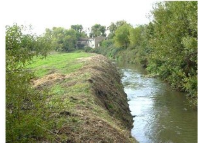
Le Vistre avant les travaux - @Compagnie des forestiers
