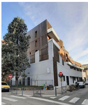
Crèche Anthoard et programme immobilier dans une ancienne chapelle
