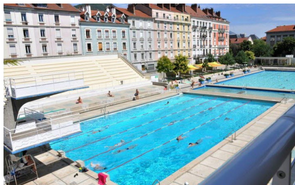
Piscine Jean Bron, aujourd'hui en bassin nordique
