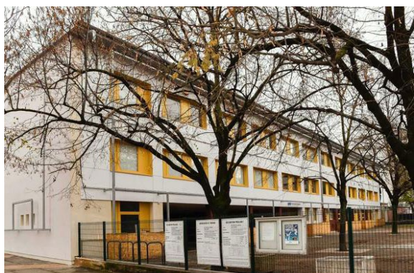
Ensemble parc et groupe scolaire rénové Joseph Vallier
