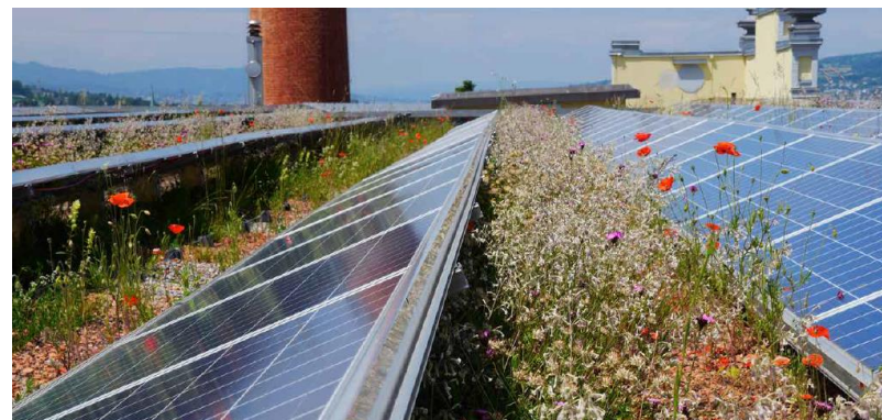
Toit biosolaire valorisant la biodiversité à Zürich (The Biosolar Roof Project) © Jonatan Maimbert
