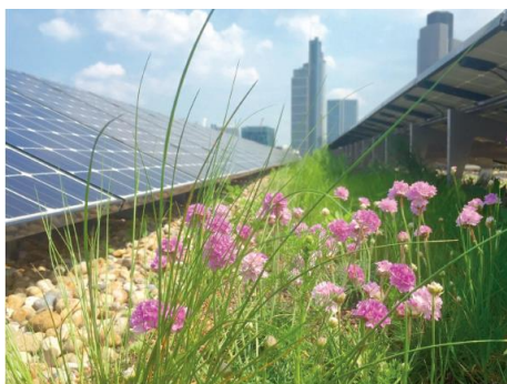
Une toiture installée sur la Standard Chartered Bank à Londres en 2015 : végétalisée avec semences et mini-mottes de plantes sauvages (un mélange d'espèces développé par livingroofs.org) et du substrat standard. ©Dusty Gedge
