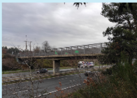
Aménagement d'un passage à faune sur l'A72 au niveau de La Foulbuse
