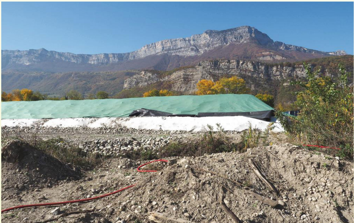
Friche Becker en cours de dépollution
