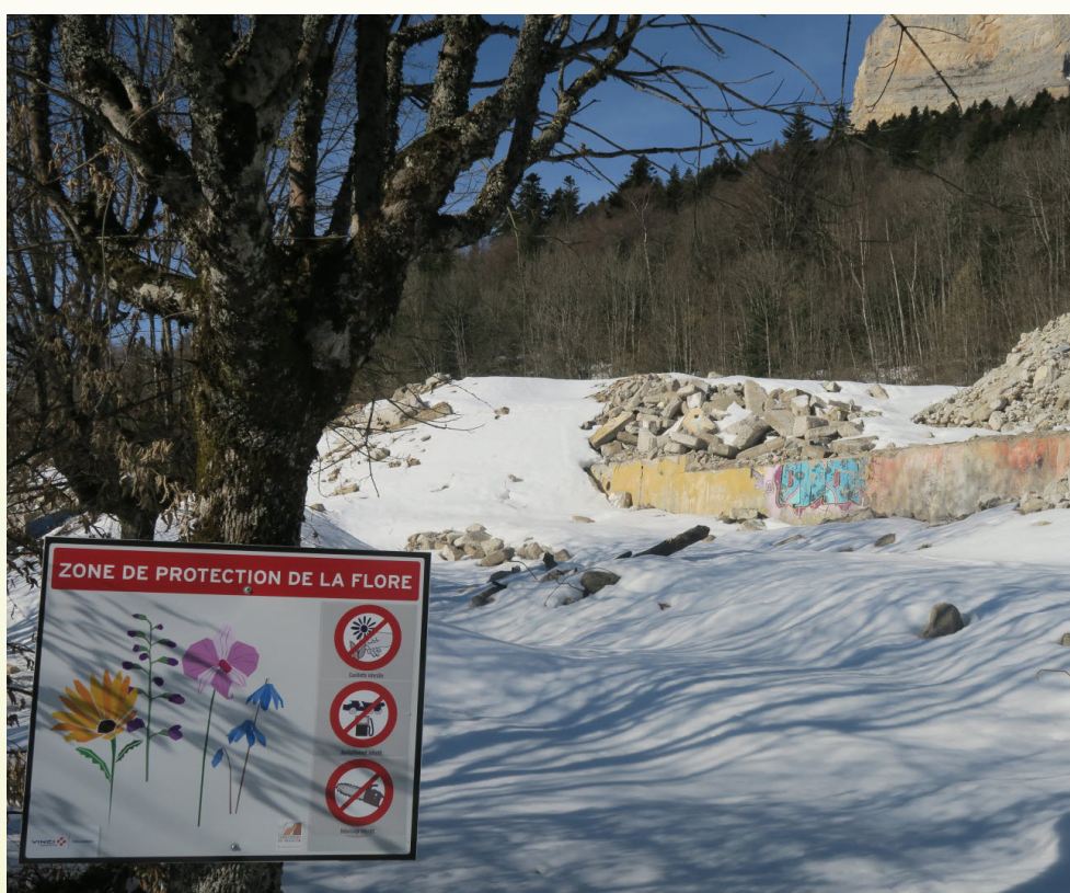
travaux de demolition du sanatorium - le dauphine.fr
