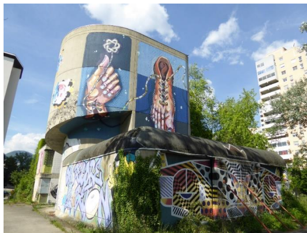
Centrale d'aspiration des déchets
