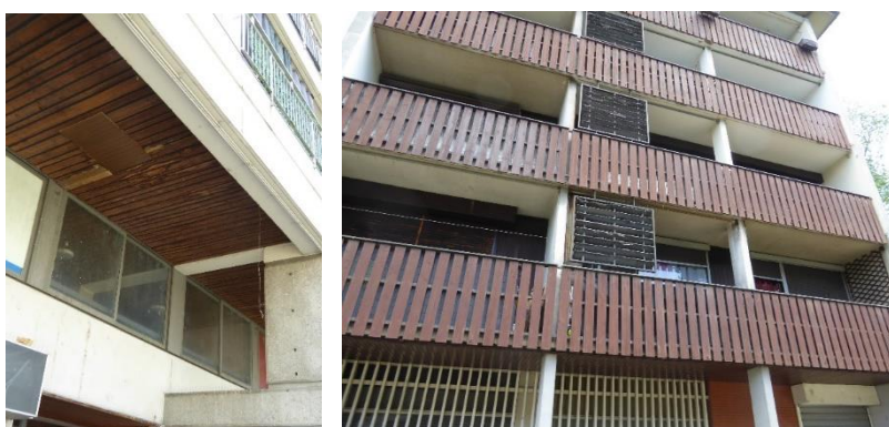
Sous-face des bâtis entourant la place de la Convention – façade du Village Olympique
