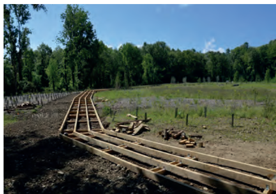
La passerelle dans la zone nature, lors de sa construction en mai 2022
