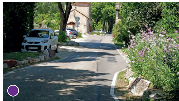
Axe routier réaménagé à Montjoux La Paillette Source : Pénélope Haas, maître d'œuvre du projet, 2021
