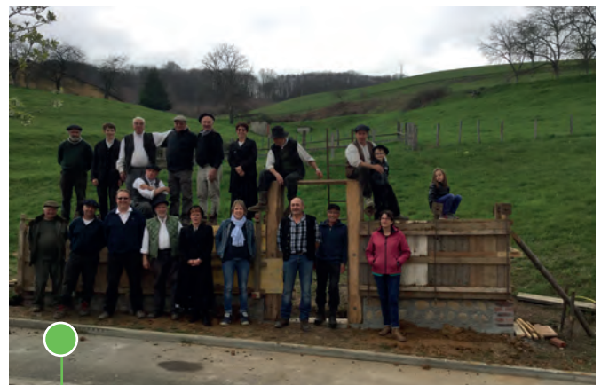
Construction du muret - source : Brion
