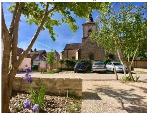
Stationnement végétalisé et enherbé, muret séparant les espaces et les usages, Chamboeuf
