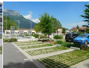
Dalles engazonnées diminuant l'imperméabilisation, Le Pont de Claix
