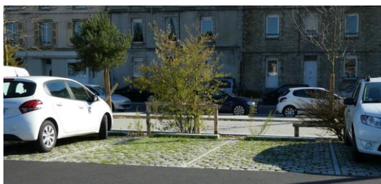
Pavés granit et joints drainants enherbés, Quimper. Source Céréma
