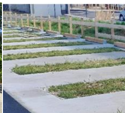
Bande de roulement en béton brossé, Valence
