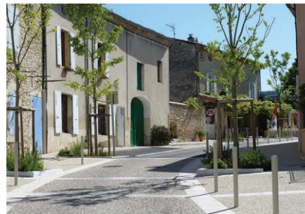
Béton désactivé, Le Poët-Laval
