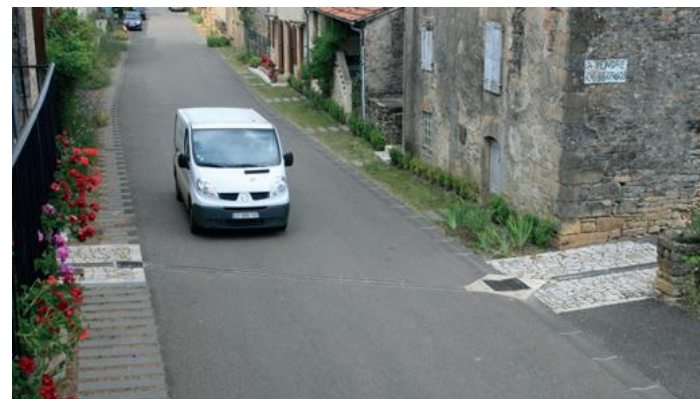
Marquage d'une intersection entre un axe circulé et une zone piétonne par des pavages de pierres et une ligne de pavés béton traversant l'enrobé
