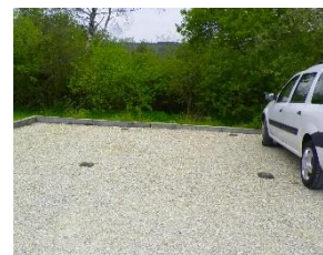
Stabilisé, St Laurent du Pont
